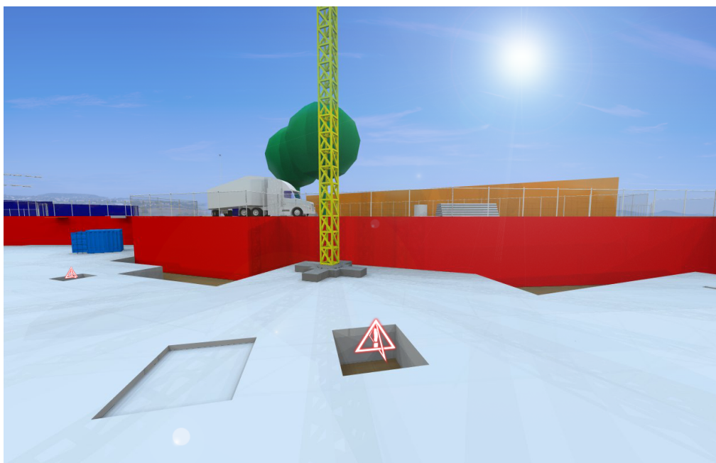
Figur 16 Nu är fler etapper gjutna. Hissgropar och försänkningar ska skyddstäckas så man undviker fall och snubbelrisk.
