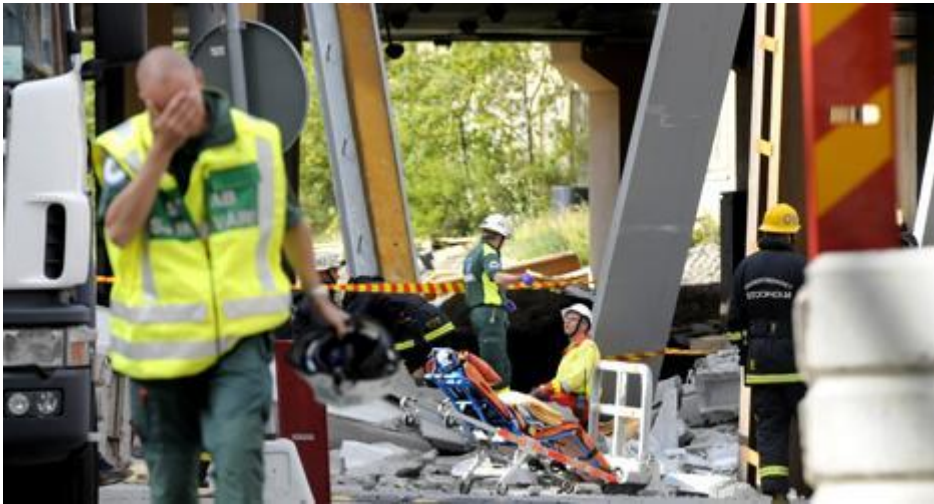
Figur 1 – Vid olyckan i Kista i juli 2008 drogs två montörer med i raset när en för vek avväxlingsbalk gav vika. Den ene omkom omedelbart och den andre ådrog sig svåra skador. /1. www.byggvarlden.se/
